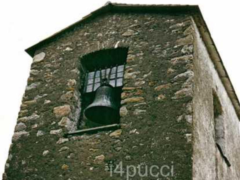
Fig. 4 – La torre campanaria.
