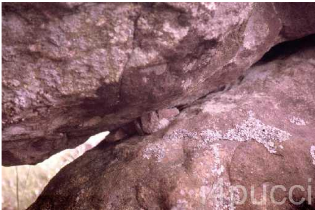
Fig. 10– Zeppes di pietra che pare ne impediscano lo scivolamento.
