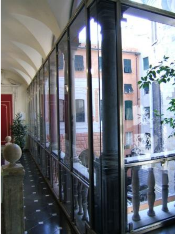
Colonne e balaustre del loggiato.
